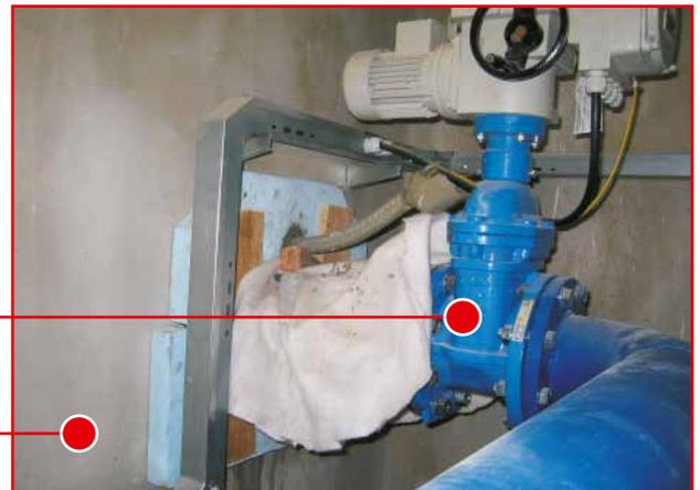
Für schmale Fugen und Spalten ist **ERGELIT-superfix 10** der dichte und dauerhafte Vergussmörtel, der die Mauerdurchführung schon nach weniger als 45 Min. sicher festhält.
