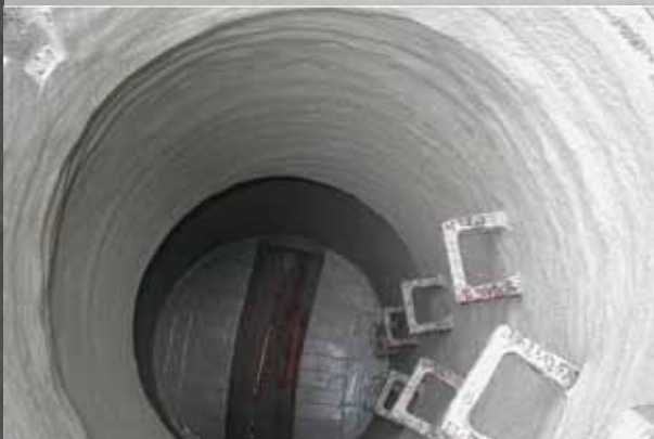
Fertig beschichteter Schacht
