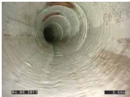
Bild 6: Seitenanschluss mit Kanaltec im Liner | Quelle: Hächler Umwelttechnik
